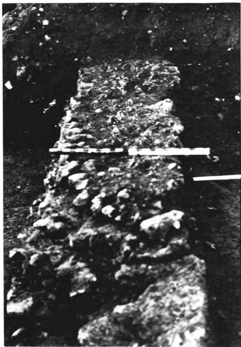
Roman Wall ( Photo. R. J. Mills).
