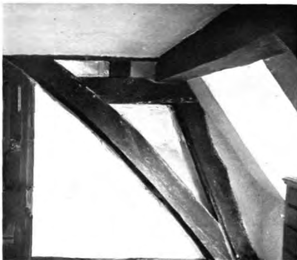
A. Hamden, Base-Cruck Truss, S. Half.
