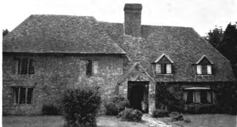
A. Hamden, Exterior from S.
